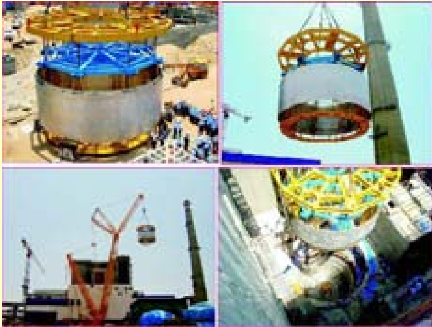
Thermal Baffle erection
