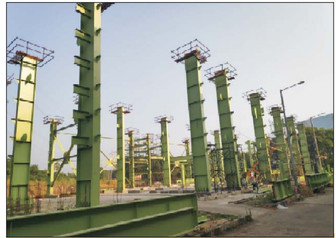
पीसीपी परीक्षण फेसिलिटी भवन का स्थापन
