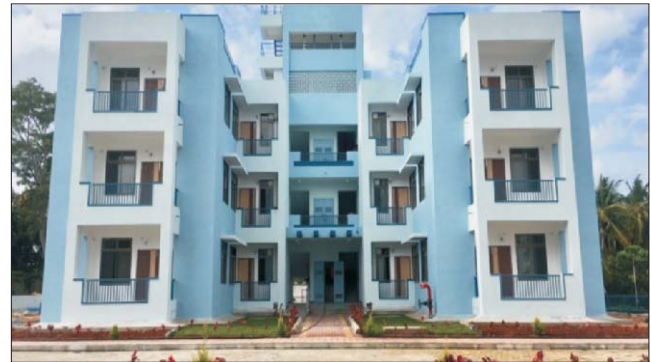
आरएमपी, मैसूरु, कर्नाटक के पऊवि आवासीय टाईप IIB के 24 फ्लैटों का निर्माण
