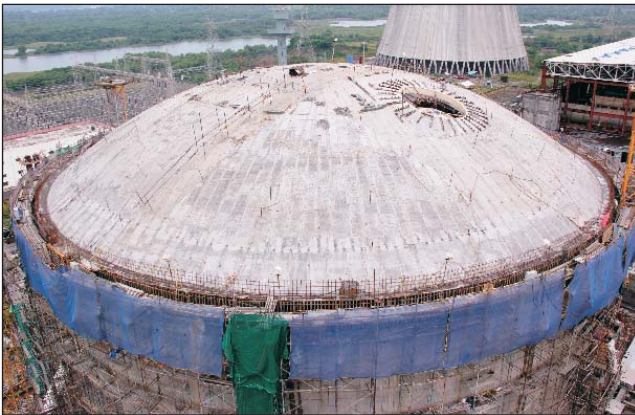
ओसी के साथ ही केएपीपी-4 रिएक्टर भवन निर्माण का कार्य पूरा हो गया है।
