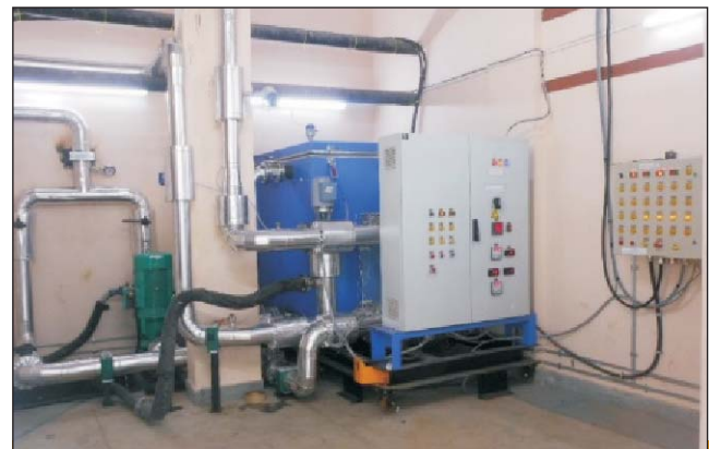
पाइपलाइन और मैनिफोल्ड सिस्टम के साथ नवीन केंद्रीकृत द्वितीयक जल पंप इकाई
