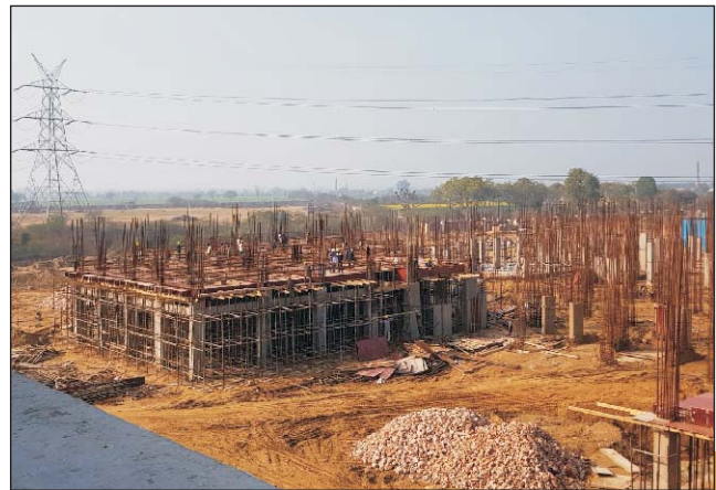
केन्द्रीय भवन का निर्माण कार्य प्रगति पर है।
